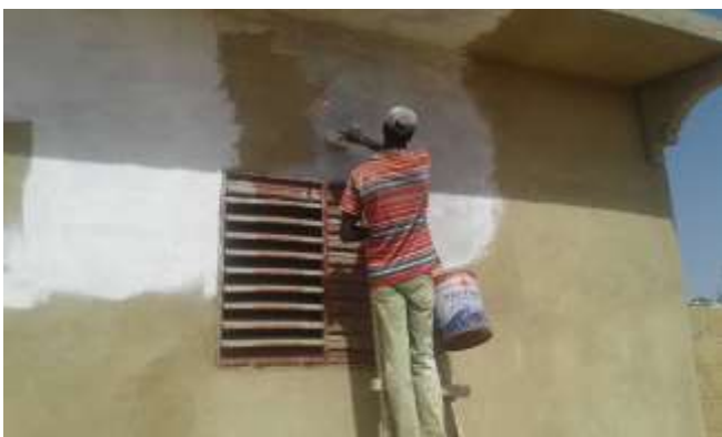
Die Mahlarbeiten sind fast fertig.
