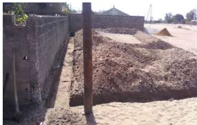
Das Fundament wurde ausgehoben
