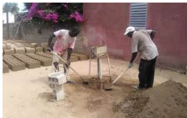
Herstellung der Hohlblockbetonsteine
