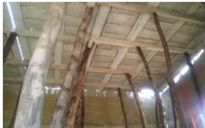
Die vorgefertigten Träger und Betonsteine für die Decke
