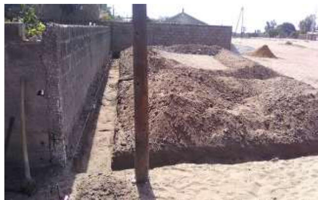
Das Fundament wurde ausgehoben
