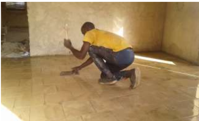
Der Fliesenleger hat inzwischen alle Arbeiten abgeschlossen.
