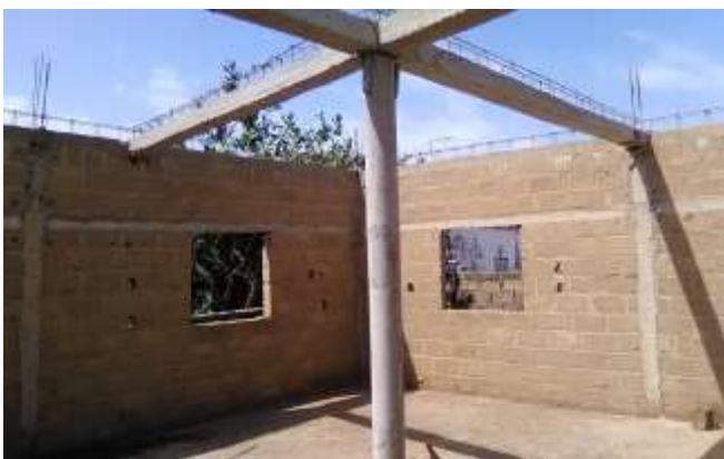
Die tragende Konstruktion für die Betondecke
