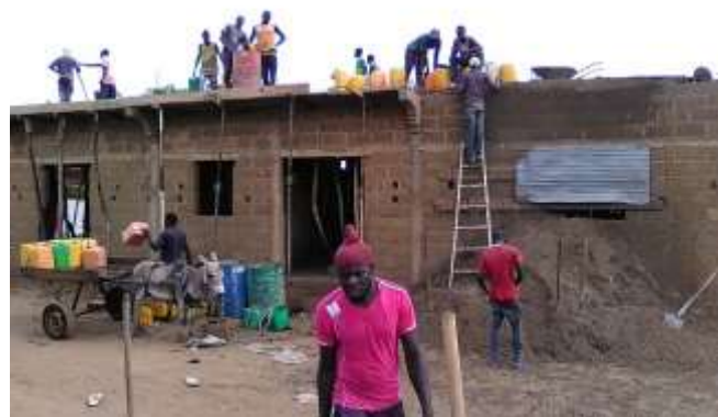
Die Betondecke wird betoniert
