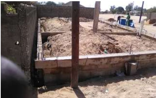
Das Fundament wurde gemauert und betoniert
