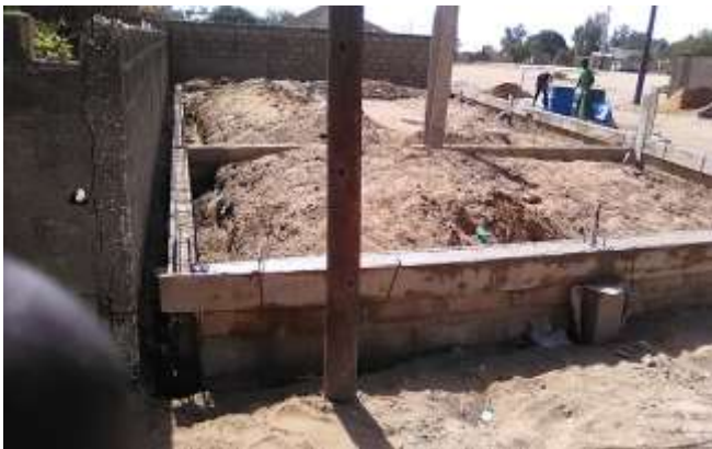
Das Fundament wurde gemauert und betoniert
