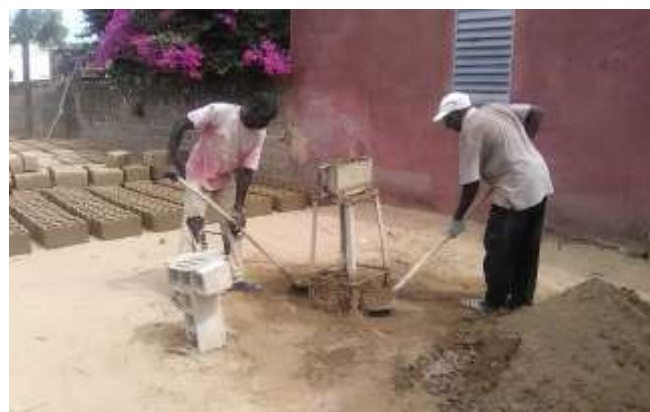
Herstellung der Hohlblockbetonsteine
