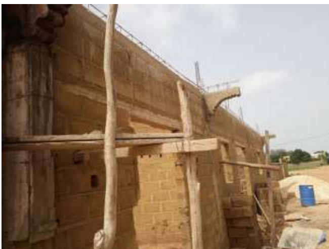
Die Außenfront des entstehenden Werkstattgebäudes
