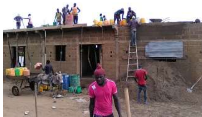
Die Betondecke wird betoniert
